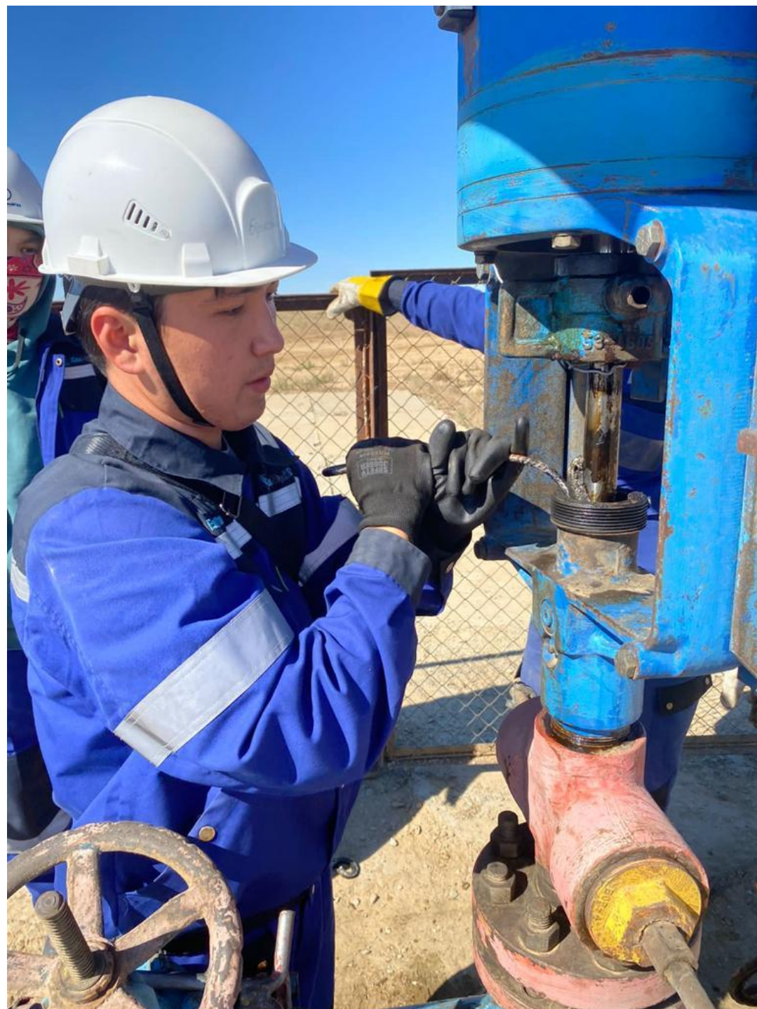
Наземная и подземная инфраструктура полигона
